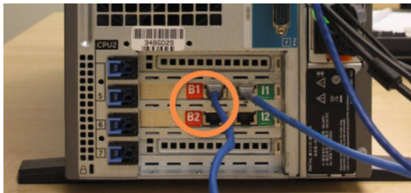
Figure 16-4: Ports du pont de contrôleur
